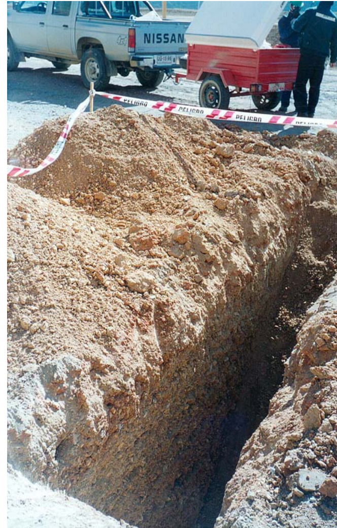
c) Calicata con maquinaria (hasta 5 m de profundidad)
